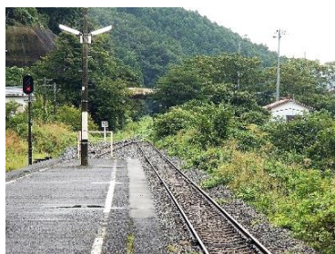
柳津駅のホームから気仙沼方面の線路を望む。線路は緑の雑草で覆われ、列車が走ることはない現実を物語っています。ここから先はBRTが担います。
